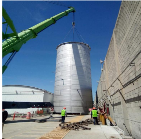
Figura 5: Izaje de reactor anaerobio en proceso
